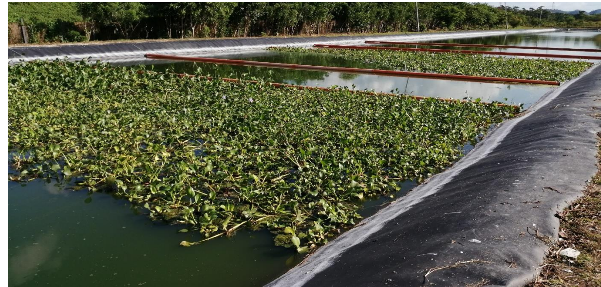
Pflanzenkläranlage in Peten, Guatemala
