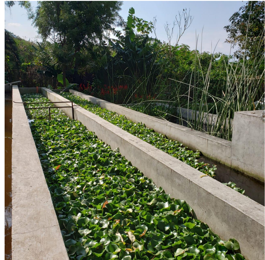
Pflanzenkläranlage in Solola, Guatemala
